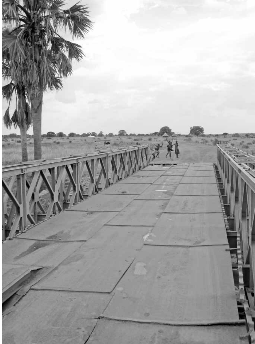
Im Süd-Sudan muss überhaupt erst eine nennenswerte Infrastruktur aufgebaut werden: Strassenbrücke bei Juba. Bild: Ruedi Küng, 2011.
